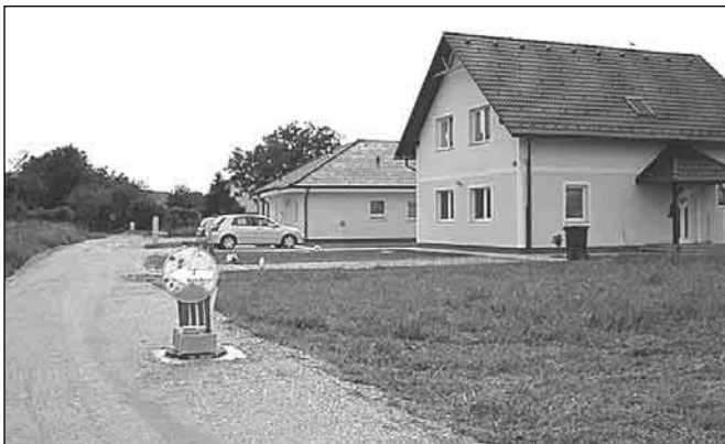
Ena od cest, pripravljenih za asfaltiranje
