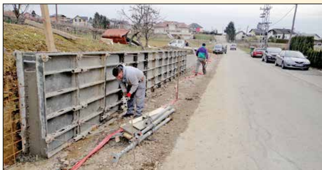
Izgradnja javne kanalizacije in pločnika ter širitev javne razsvetljave na delu Morske ceste v naselju Morje
