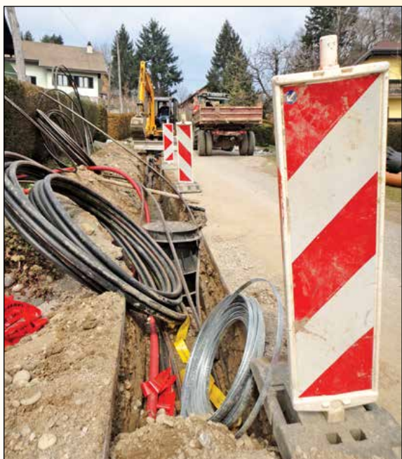
Izgradnja javne kanalizacije in sopolaganje elektro in TK vodov v Strmi ulici v Morju
