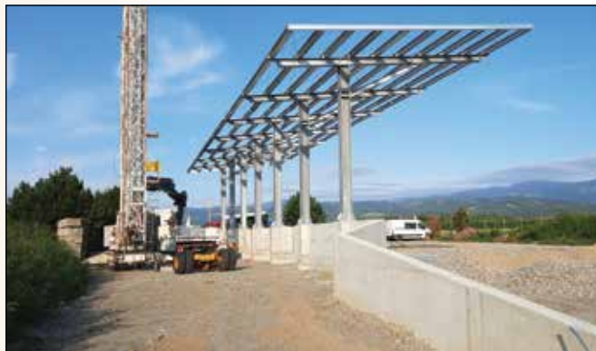
Izgradnja Zbirnega centra za ločeno zbiranje kosovnih odpadkov v Račah
