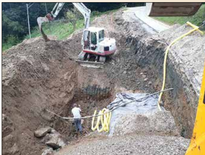
Sanacija plazov v Loki pri Framu; avgust 2021
