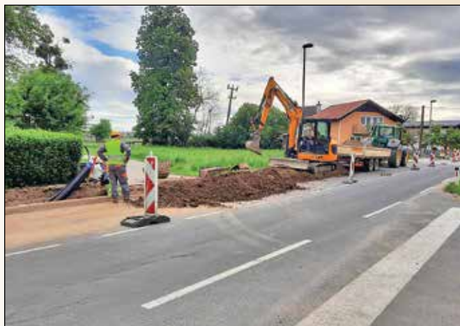
Sanacija javnega vodovodnega omrežja na delu Ptuijske ceste v Račah
