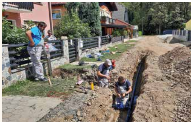
Zamenjava vodovodnega omrežja v Gozdni ulici v Račah
