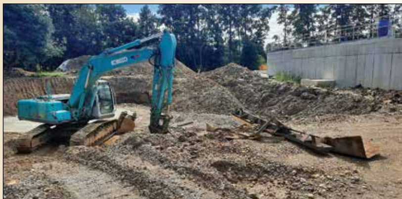
Izvajanje izkopov po rušitvi stare ČN; 2. 9. 2021
