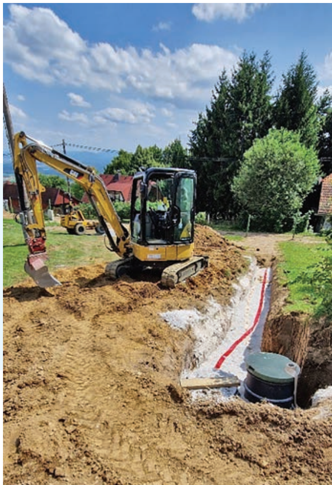
Izgradnja fekalne kanalizacije v Račah
